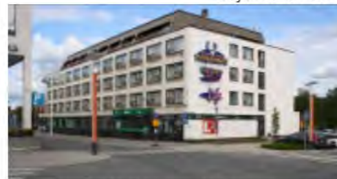
Vuoden 1973 laajennus Pohjanpuistikon ja Koskikadun risteyksessä. Laajennusta ei esitetä suojeltavaksi
