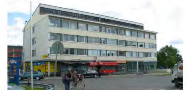
1960-luvun tyyppillinen nauhaikkunoin ja lasiseinäisellä maantasokerroksella varustettu asuin-liikerakennus Kansakadulla. Rakennuksen on suunnitellut arkkitehti Simo Lumme
