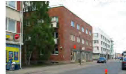
Rovakadun ja Ukkoherrankadun kulmaan sijoittuva 1954 valmistunut asuin-liikerakennus on osin valkeaksi rapattu ja osin punatiilinen.
