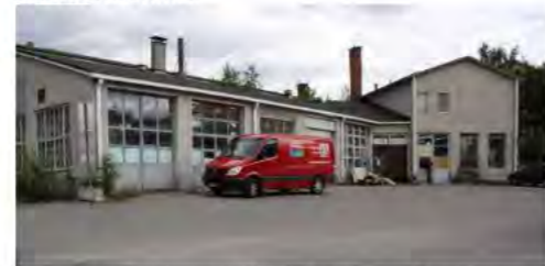
Vapaudentien varren 1950-luvun autokorjaamo ja liikerakennus.
