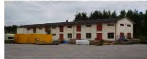
Aittatien varressa sijaitseva 1950-luvun kaksikerroksinen varastorakennus.
