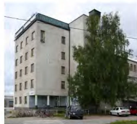
1957 valmistunut SOK:n entinen liikerakennus sijoittuu näkyvästi valtatie 4 varteen
