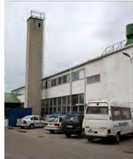
Suosiolan alueella Varastotien varressa sijaitseva Caterpillar-korjaamo Witractor edustaa arkkitehti, professori Aarno Ruusuvooren varhaistuotantoa. U-muotoinen kaksikerroksinen teollisuuskortteli valmistui 1957.
