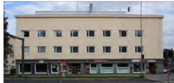
Toripuistikko 8 toimisto-liikerakennus 1940 luvulta.
