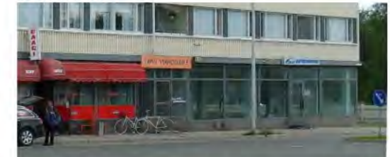
Kansakatu 2 1960-luvun lasiseinäinen myymälätila avautuu lasiseinäisenä myös Haltuskadulle.
