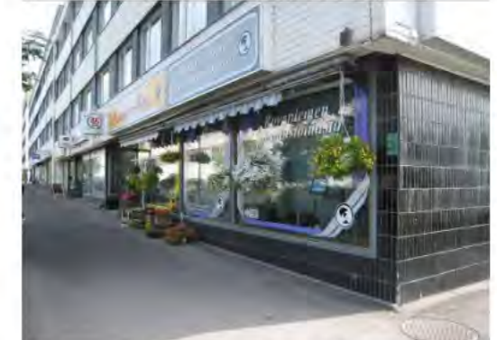
1963 valmistunut Rkm Toivo Lukkarinniemen suunnittelema asuin-liikerakennus, Korkalonkatu 2. Maantasokerroksen verhouksessa on käytetty Aallon suosimaa mustaa sauvalaatta.
