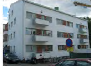
Rovakadun ja Ukkoherrankadun kulmaan sijoittuva 1954 valmistunut asuin-liikerakennus on osin valkeaksi rapattu ja osin punatiilinen.
