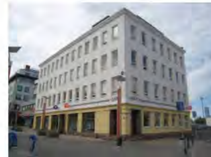
Pohjolan Osakepankin 1936 toteutettu liike- ja asuinrakennus noudattaa Oiva Kallion umpikortteleihin perustunutta kaavaa ja sen sallimaa neljän kerroksen enimmäiskorkeutta. Rakennuksen on suunnitellut arkkitehti G.Strandberg.
